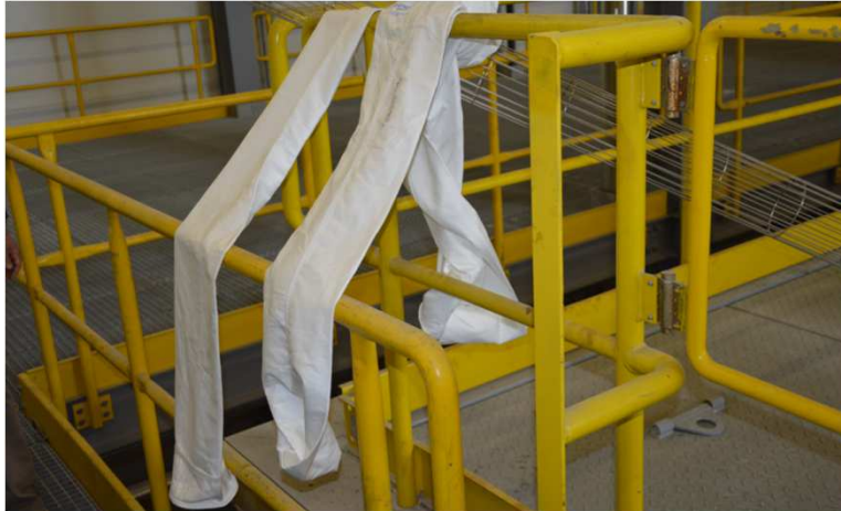
Nové filtrační rukávce před instalací
