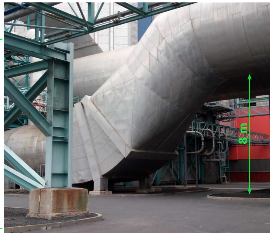
spalinovod od ESP
